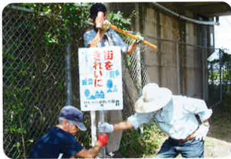
告知看板設置 (8月29日)
